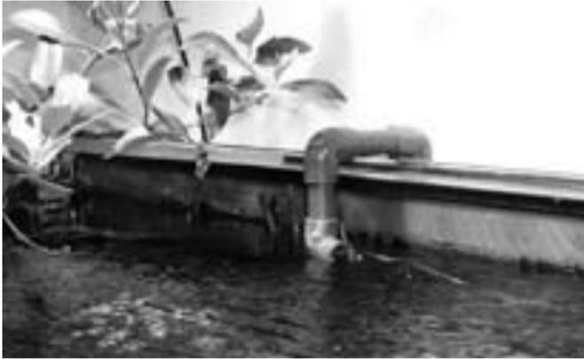
**Störung: Der Wasserdurchfluss durch Zulauf und Rückförderpumpe ist geringer als erwartet.**
